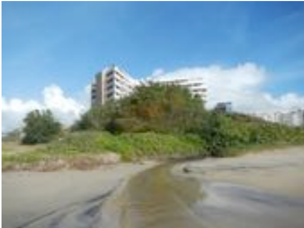
Aguas abajo sub-estación de Bombeo Playa Real.
