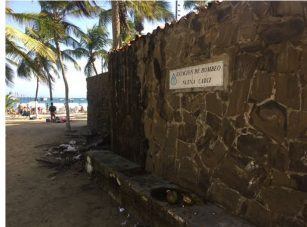
Estación de Bombeo Nueva Cadiz (Bahía Dorada)
